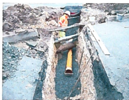
Pose de canalisation
