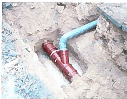
Branchement sur canalisation existante
